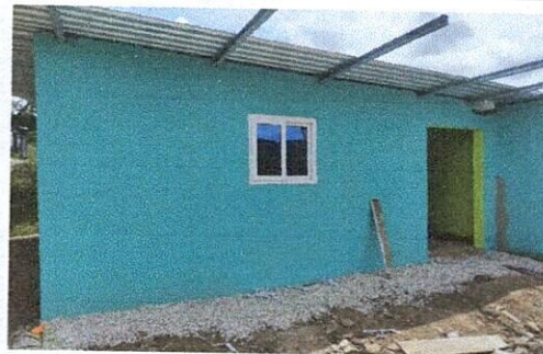
Foto 6 : AMPLIACION DE COCINA
