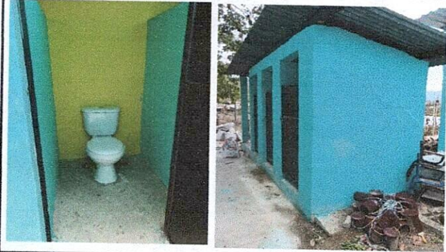
Foto 1: REMODELACION DE SANITARIOS
